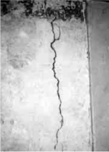
19. *Fessurazione profonda visibile nel vano scale a ovest.*
