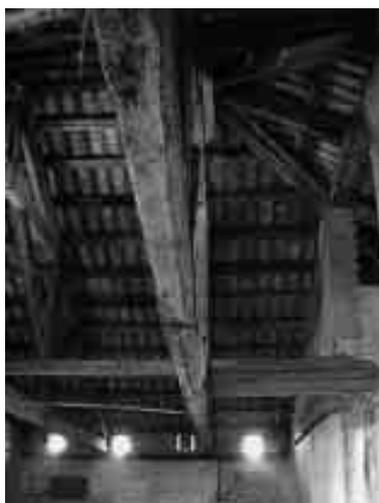
10. Le due capriate principali disposte parallelamente sono collegate da una capriata disposta ortogonalmente la cui catena composta è visibile nella foto.
