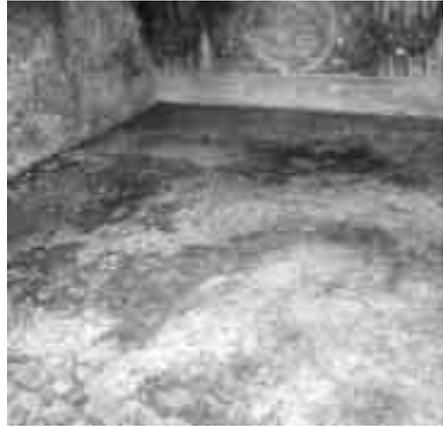
18. *Erosione per usura della pavimentazione del vano s.-o. del piano rialzato.*
