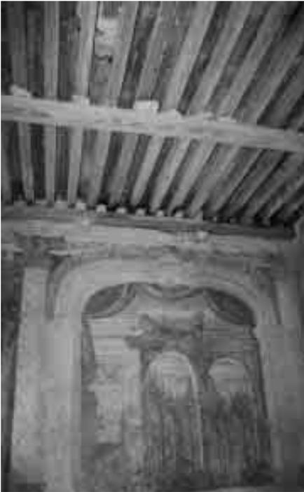
12. *Travi del solaio del vano nord-est al primo piano. Data la notevole inflessione degli orizzontamenti è stata disposta una trave rompitratta.*
