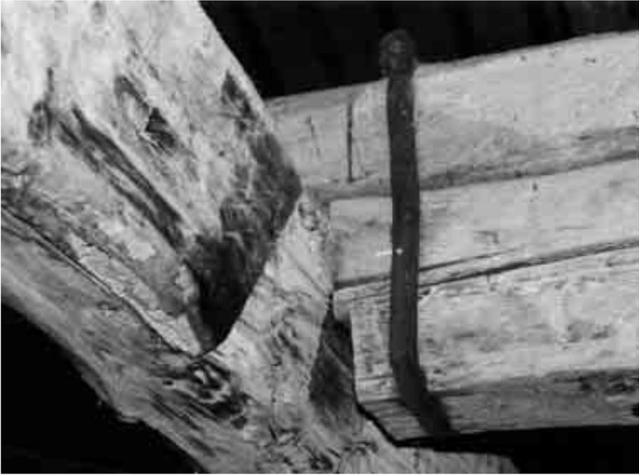
24. *Sconnessione della giunzione fra catena della capriata principale e catena trasversale con conseguente deformazione del presidio metallico.*
