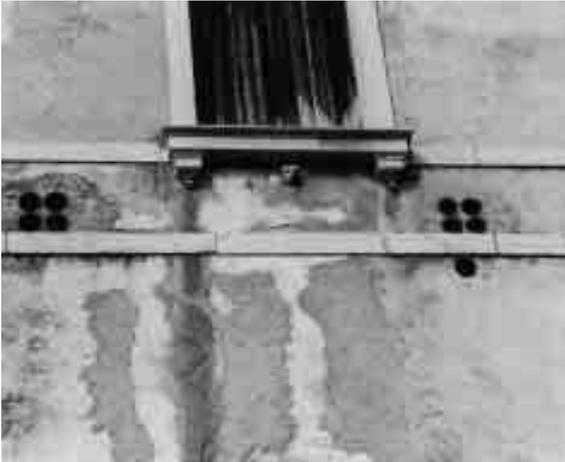
5. *Porzione muraria del prospetto est. Parte dell'intonaco è stato risarcito con malta di cemento.*
